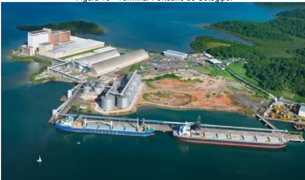
Figura 10 - Terminal Portuário de Cotegipe.
