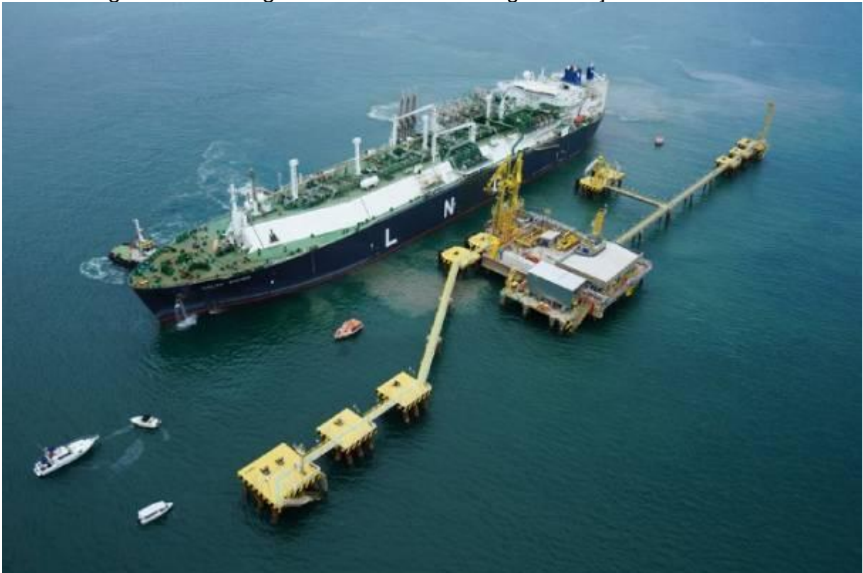
Figura 16 - Vista geral do Terminal de Regaseificação da Petrobras.
