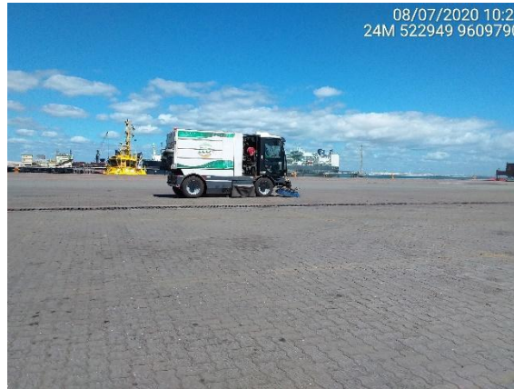
Figura 5 – Máquina de limpeza do pavimento na área de operação.
