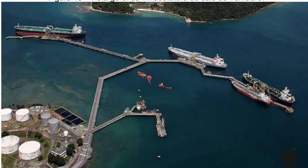
Figura 15 - Vista geral da infraestrutura de cais do Temadre.
